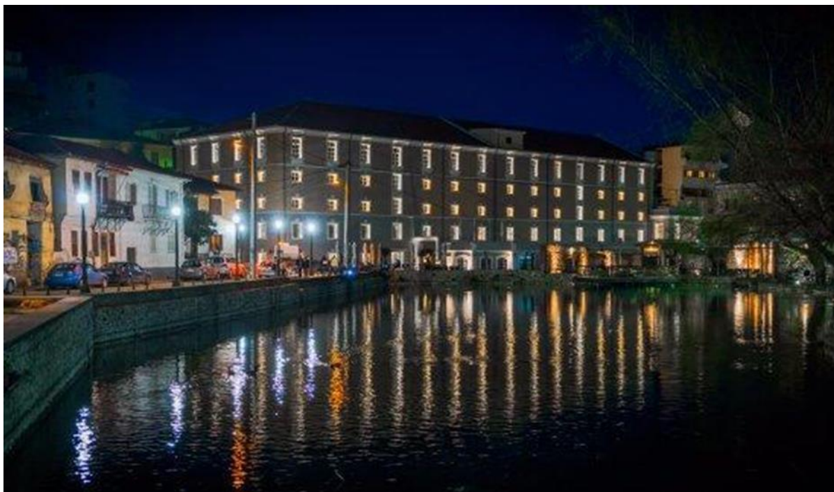
Εικόνα 11. Hydranta Grand Hotel, ανακαινισμένη παλιά αποθήκη καπνού
