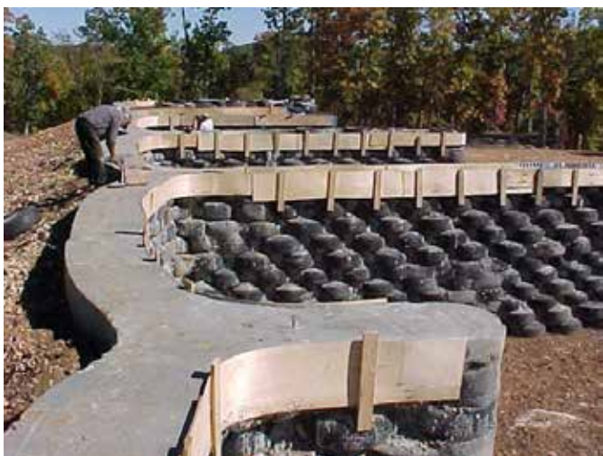
Фигура 46. Използване на стари гуми в строителството. Източник: homedit.com
