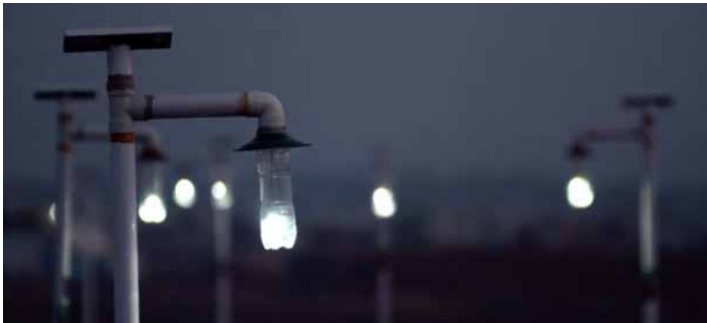
Фигура 40: Улично соларно осветление с дифузия от пластмасови бутилки, Хаити. Източник: literoflight
