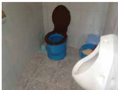
Фигура 25: Тоалетна с разделяне на урината. Снимка: Земя завинаги
