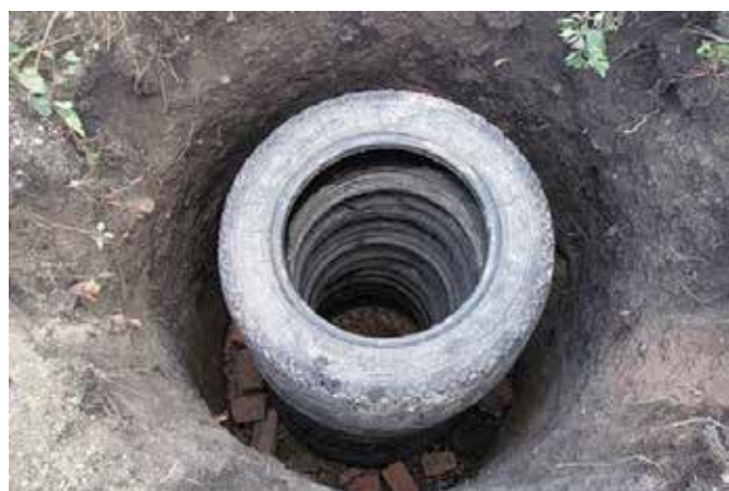
Фигура 5: Септична яма изградена с гуми Източник: decoexpo.com
