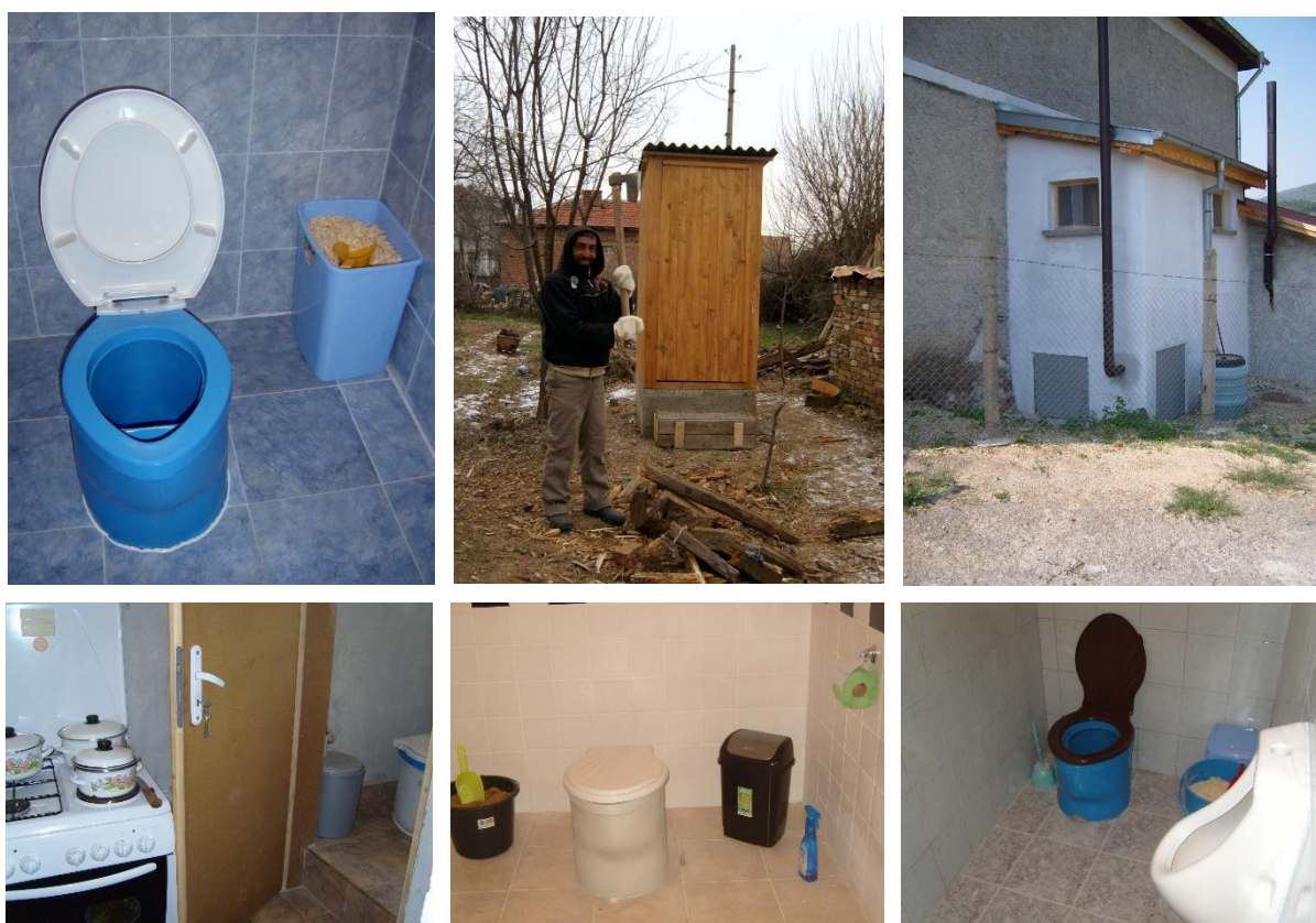
Figura 25. Toaletă uscată cu deviere a urinei. Foto: Earth Forever
