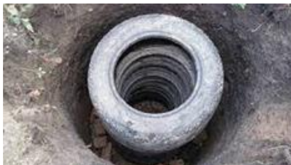
Figura 5. O groapă de infiltrare din anvelope. Sursa: decoexpo.com
