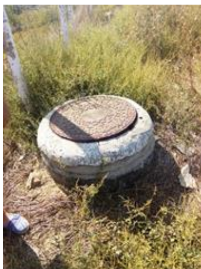
Figura 2. O fosă septică tipică dintr-o zonă rurală a Moldovei
