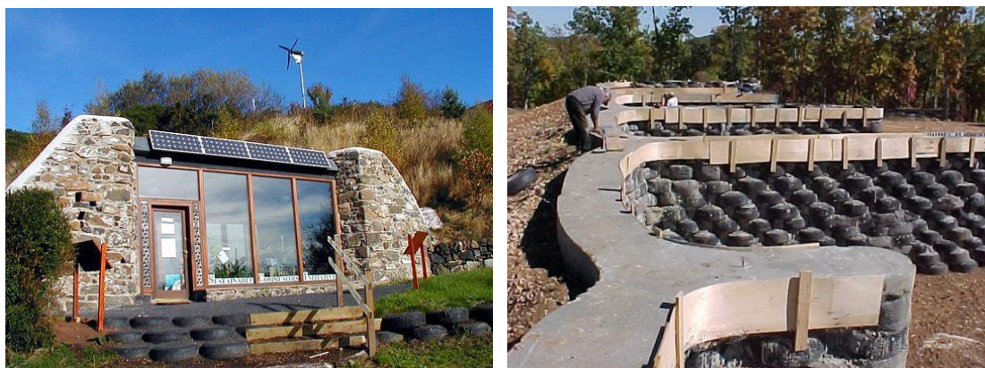
Figura 46. Reutilizarea anvelopelor uzate în construcții. Sursa: homedit.com
