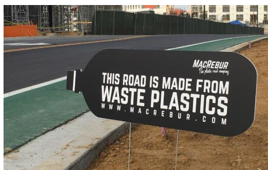
Figura 35. Drum din plastic în Aberdeenshire, Scoția. Sursa: earthdecks.net
